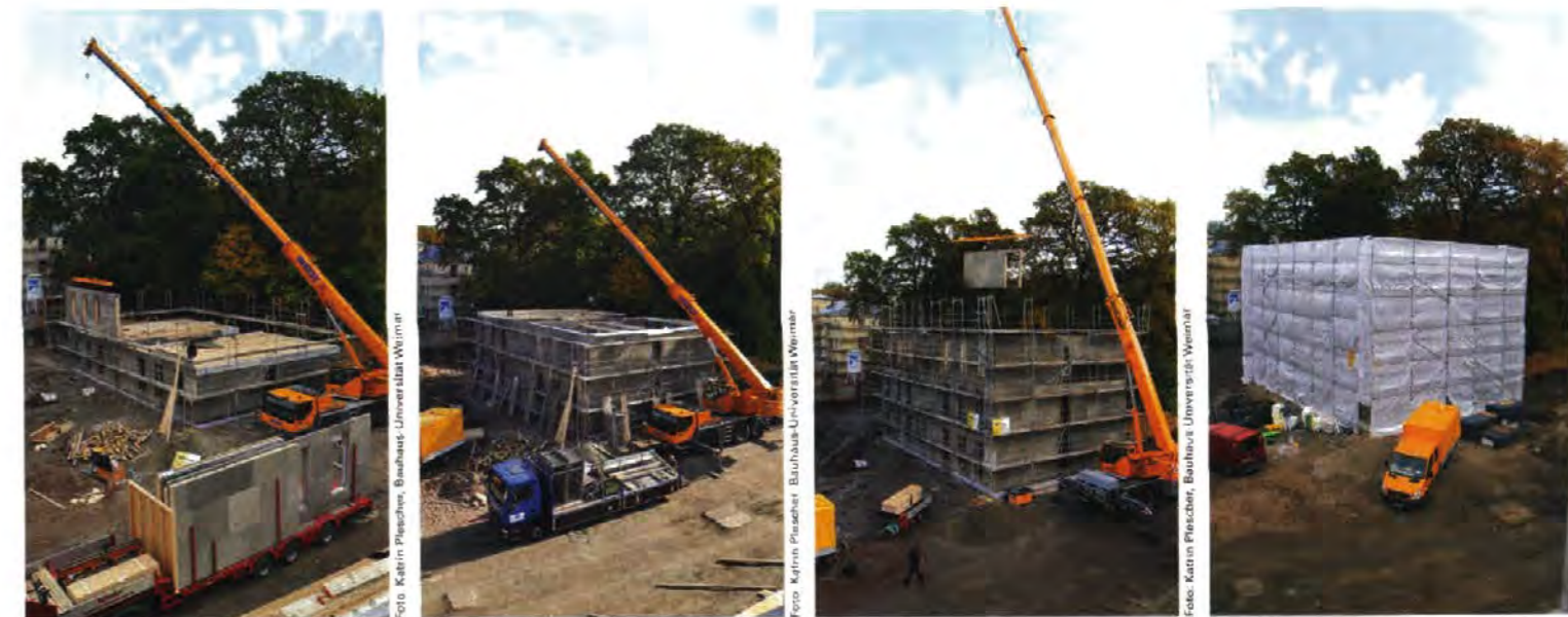
Das Material Holzbeton verbindet die Eigenschaften eines massiven Baustoffs mit den Vorteilen der Holzrahmenbauweise. So kann die Montage der Fertigteile auf der Baustelle in kürzester Zeit erfolgen
