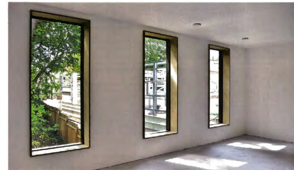
In der Langzeitbetrachtung werden Material und Gebäudetechnik analysiert
