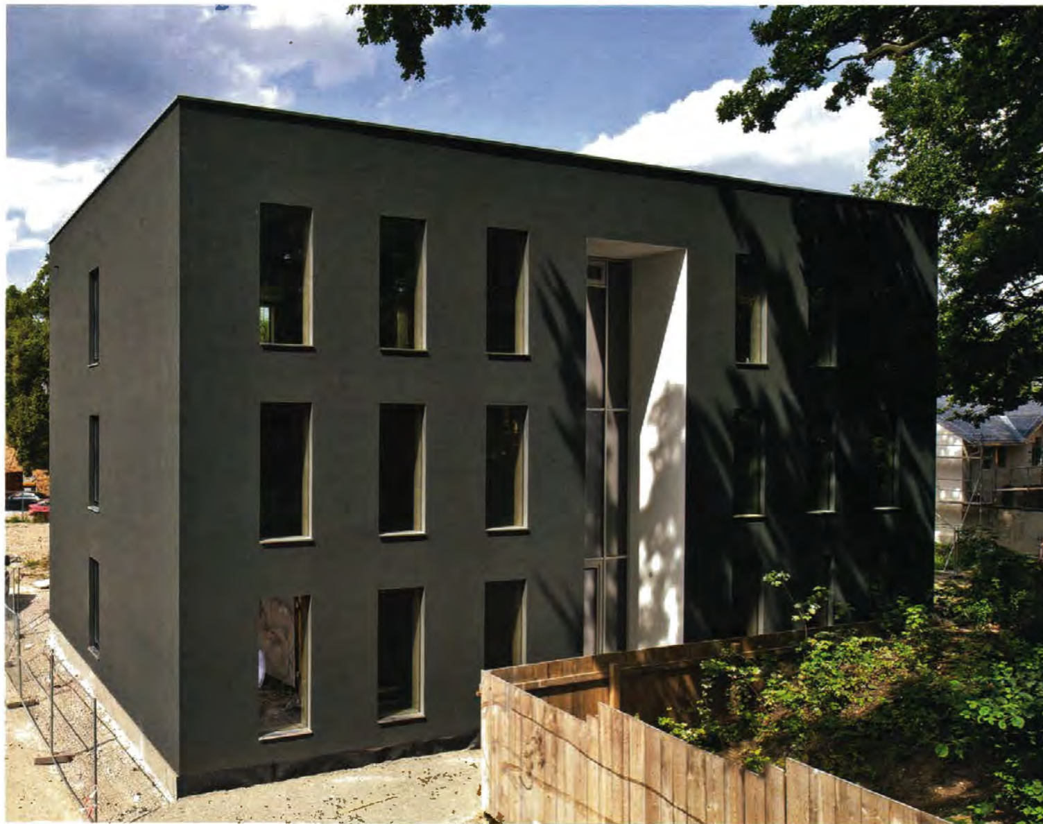
Seit Herbst 2010 wird das green:house als Experimentalbau realisiert
