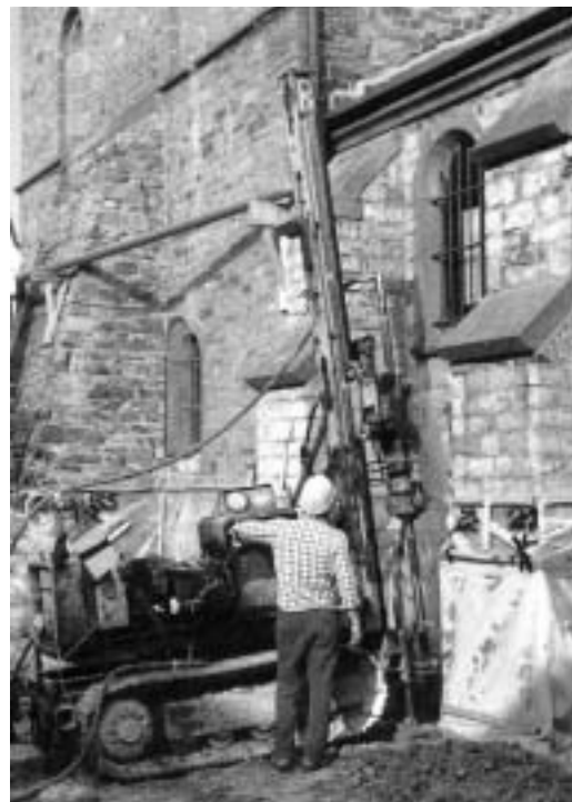
Bild 4: Herstellung der HDI-Säulen unter der Außenwand nach Bild 3 (Werksfoto Bauer, Schrobenhausen)
