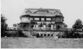
Ostansicht des Hauses Hohenhof in Hagen.
