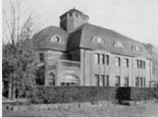
Südseite der Villa Schulenburg in Gera.
