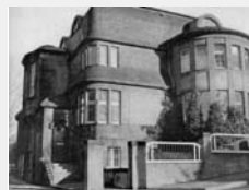
Straßenseite des Hauses Rudolf Springmann in Hagen.
