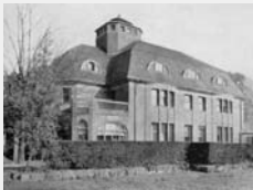
Südseite der Villa Schulenburg in Gera.
