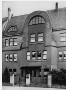
Ansicht vom Haus Fröse in Hannover.
