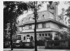
Straßenansicht vom Haus Körner in Chemnitz.
