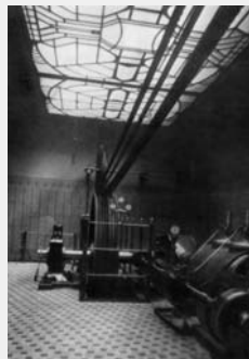
Blick in den Maschinensaal der Firma Vorster in Hagen.
