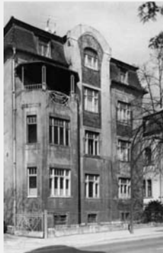
Ansicht von Südosten des Miethauses Menzel in Weimar, Aufnahme 1996.
