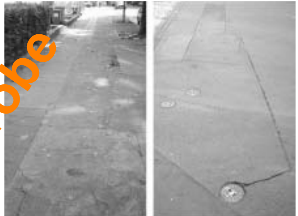
Abb. 1.30: Beispiele schlecht ausgeführter „Straßenreparatur“
