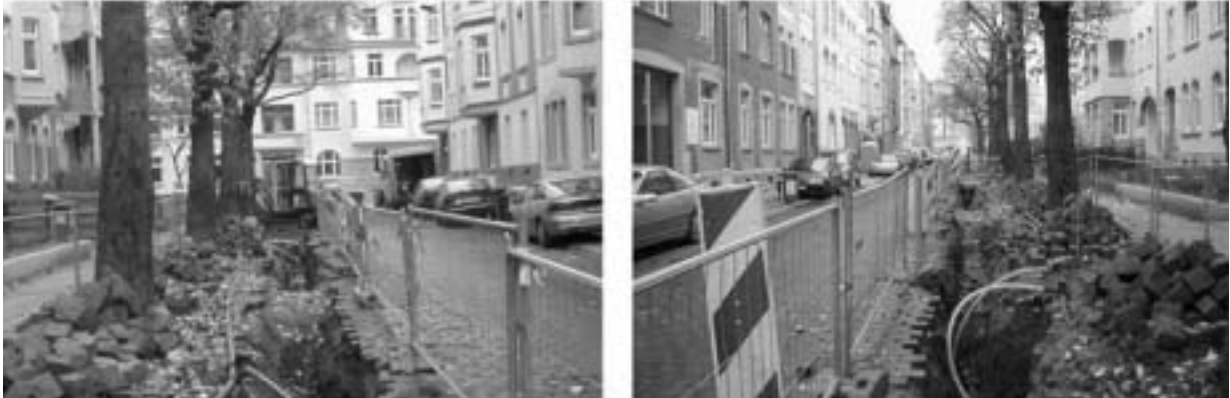
Abb. 1.7: Schädigung des Wurzelbereiches durch „konventionelle“ Neuverlegung
