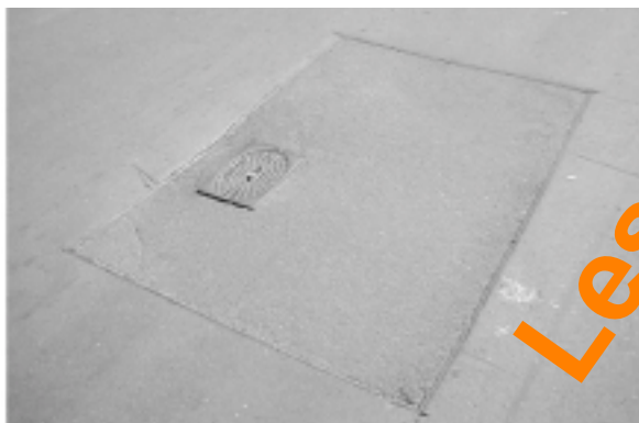
Abb. 1.27: „Flickstelle“ nach Austausch eines Hydranten
