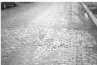
Abb. 1.14: Straßenschäden nach kurzer Liegezeit des Pflasters
