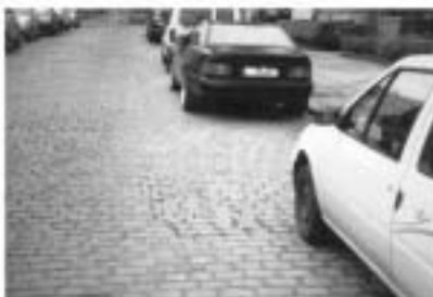
Abb. 1.14: Straßenschäden nach kurzer Liegezeit des Pflasters
