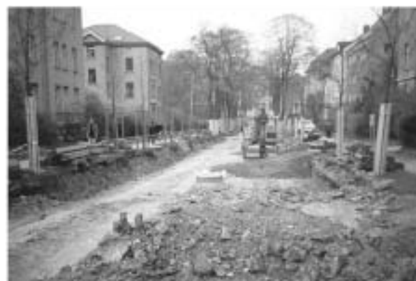
Abb. 1.6: Straßenerneuerung und Baumschutz
