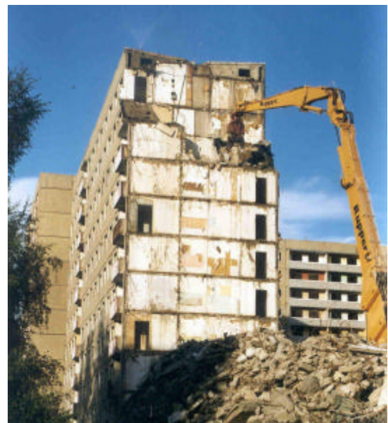
Bild 1: Abbruchbeton eines Stadions als Souvenir (links), Abbrucharbeiten an Plattenbauten (rechts)
